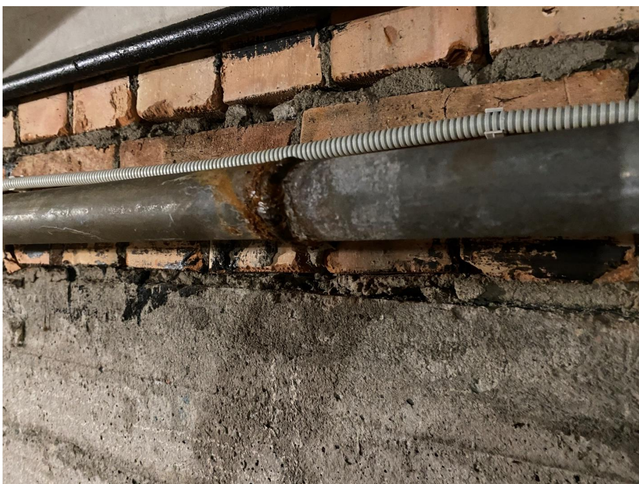
Рис.1. Пример . Состояния разводки системы водоснабжения.
